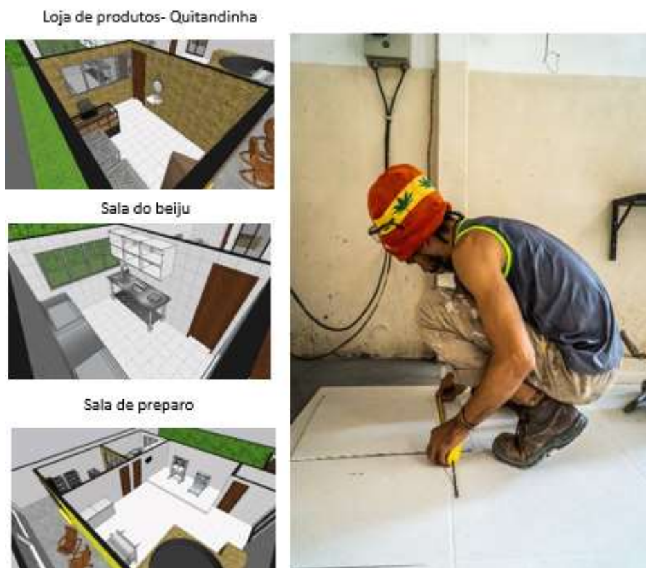
Figura 9 –Reforma da Casa de Farinha
