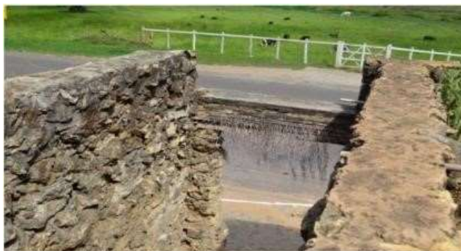
Figura 12 - Entrada do terreiro Filhos de Obá. Fonte: Juliane Barbosa, 2016.
