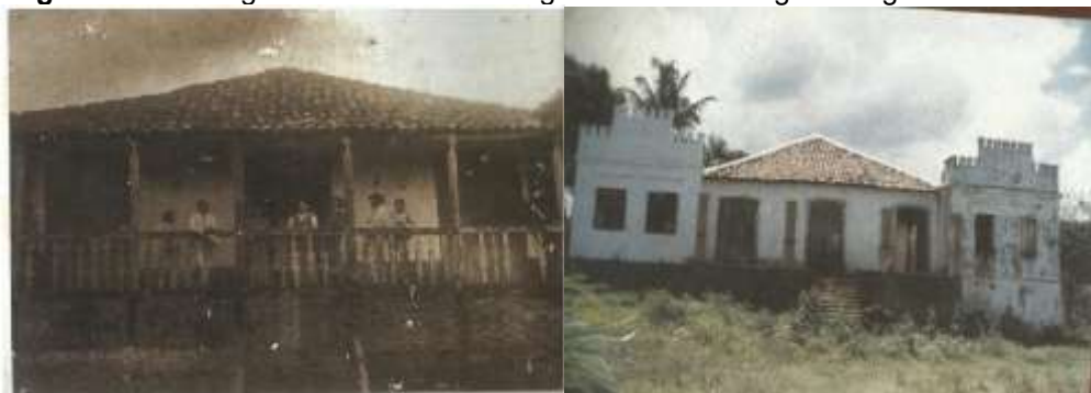
Figura 4 e 5: Antiga Casa Grande do Engenho Buraco D'água- Alagoa Grande-PB.
