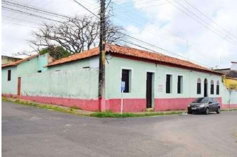
Figura 6 – Fachada da Casa das Minas
