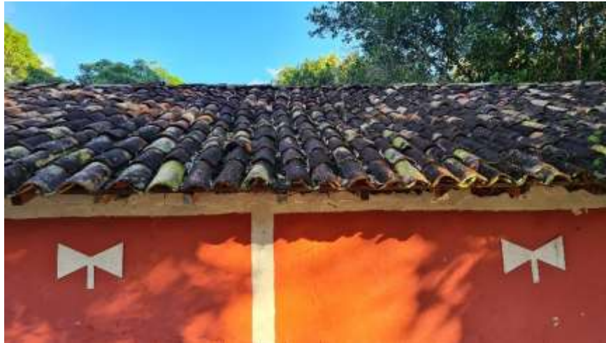
Fig.6 – As telhas artesanais, o chão batido pelos pés da própria fundadora da casa, as paredes de taipa, a estrutura de madeira retirada do próprio quintal da Roça. O fazer como símbolo da manutenção do saber ancestral. Fonte: Ilê Axé Icimimó Aganju Didé , Cachoeira, Bahia. Foto do autor. Data: foto A - 30 de julho 2022 e foto B - agosto 2021.
