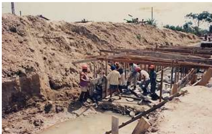
Figura 6- Fotografia das obras do canal de drenagem do bairro.
