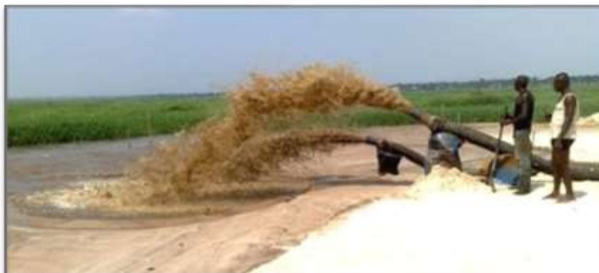
Fig. 3: Operários sem EPI's, trabalham na deposição de areia para formação das ilhas de La Cité du Fleuve (RDC). Fonte: https://www.bbc.com/news/world-africa-14595625
