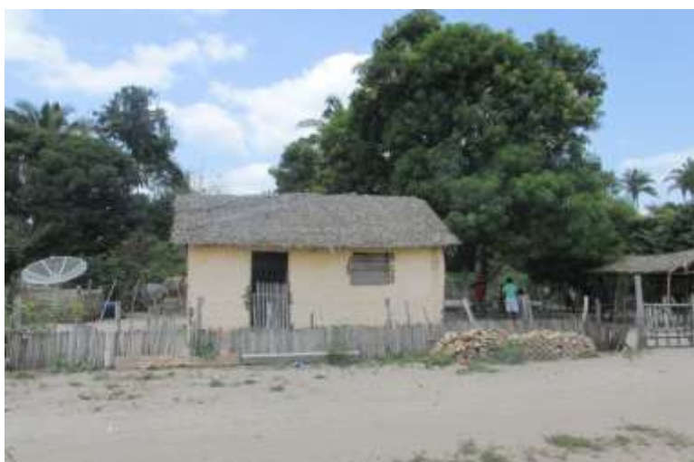
Figura 4: Casa de taipa de mão revestida na fachada, São Miguel dos Correias, Cajari, Maranhão (Latense, 2017)
