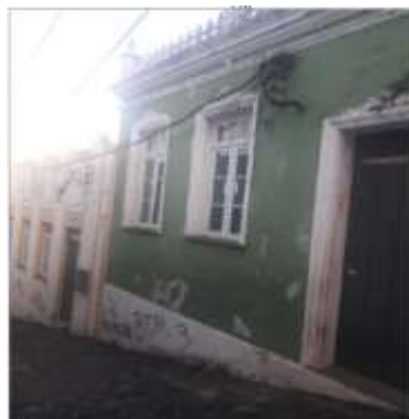
Ilustração 12: Fachada Principal, Casa nº. 02 Fonte: Arquivo Pessoal
