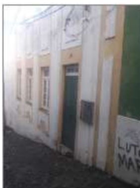
Ilustração 11: Fachada Principal Casa nº. 06 Fonte: Arquivo Pessoal
