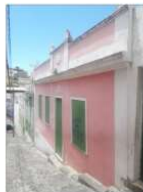
Ilustração 13: Fachada Principal Casa nº. 04 Fonte: Arquivo Pessoal
