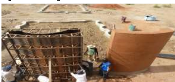
Figura 12: Montagem de Painéis.
