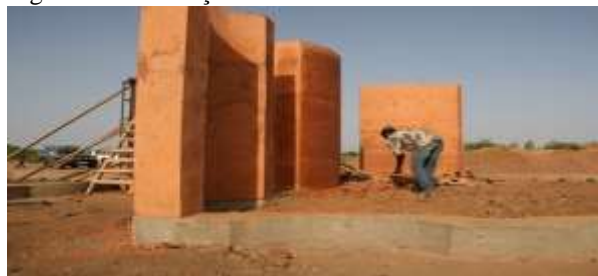
Figura 13: Colocação dos Painéis.
