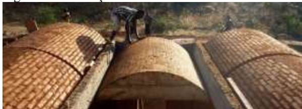
Figura 7: Construção de Abóbadas.
