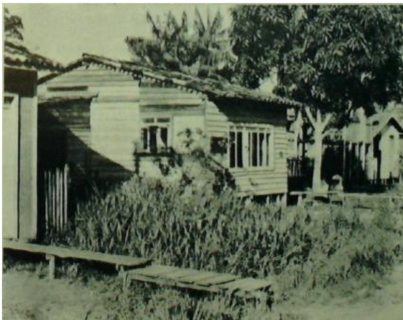
Figura 2 – Casas e passarelas de madeira características do Bairro da Terra Firme na década de 50. Fonte: PENTEADO, 1968, p. 334.
