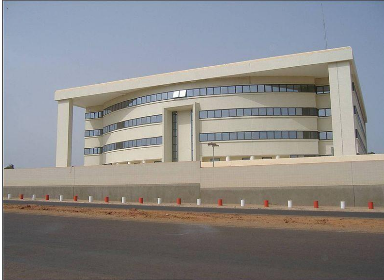
Figura 9: Edifício do Banco Nacional da Guine Bissau. Todo climatizado e com fortes problemas de temperatura ambiente devido a escassez de energia. .
