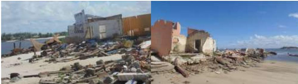
Figura 12 – Construções erodidas. Foto produzida pelo próprio autor.
