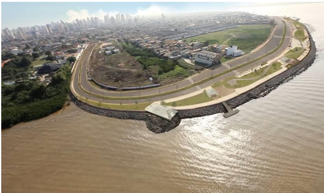
Figura 3: Primeira etapa do Portal da Amazônia integrado as obras de infraestrutura do PROMABEN. Fonte: play47.blogspot.com
