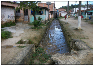
Figura 9 - Macrodrenagem Fonte: Registro pessoal da autora, 2010
