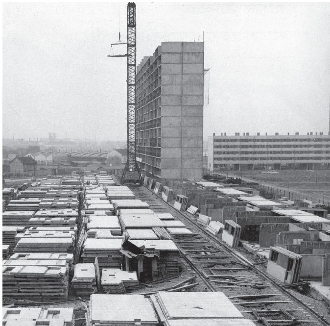
Publicado no artigo de J.-P. Robert, "Álbum Terrível de Le Courneuve ", na Architecture d'aujourd'hui (No 259, Outubro de 1988). Construção das Barres em La Courneuve .
