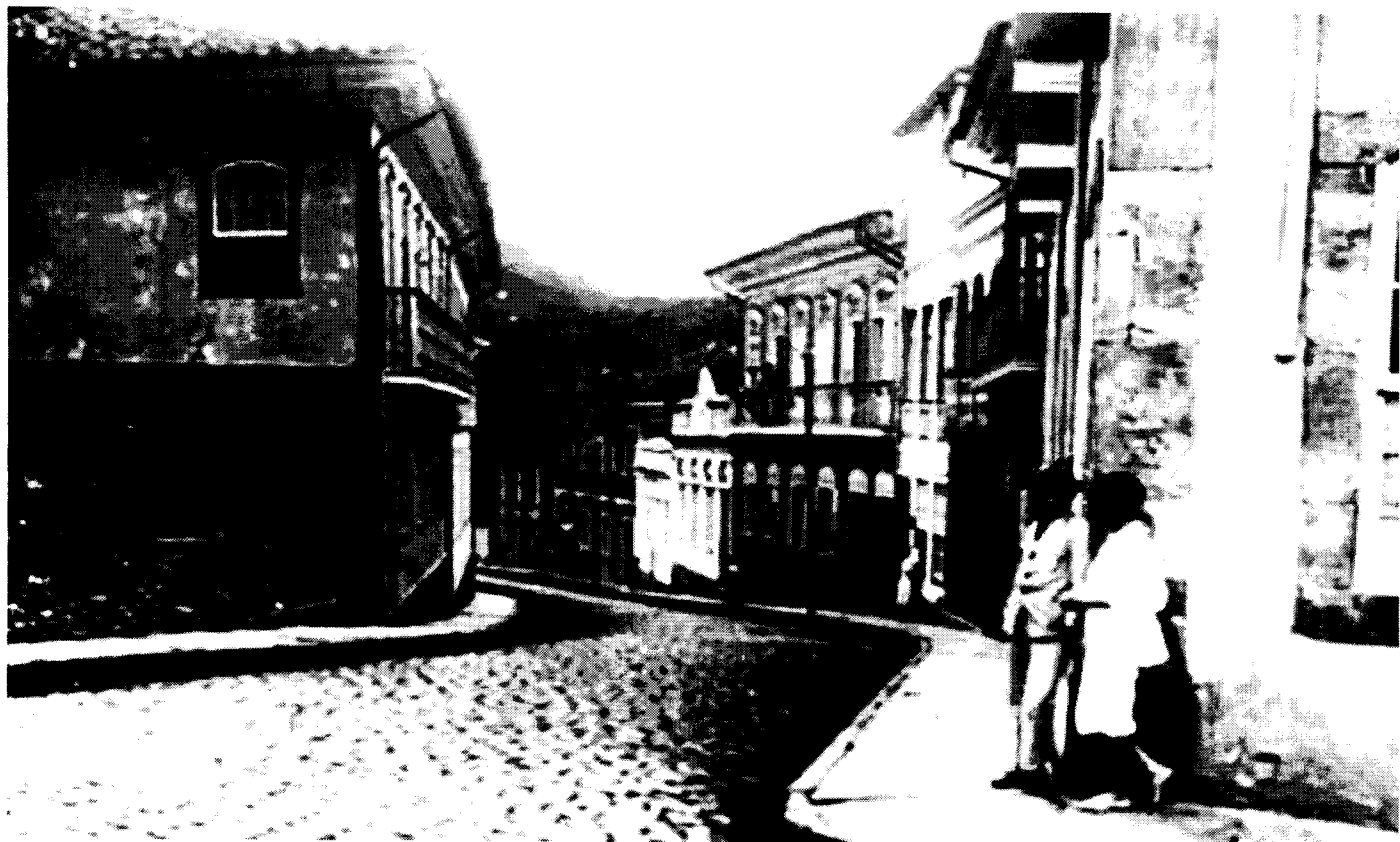
Vista de Ouro Preto no século passado. Fonte: Biblioteca Nacional-RJ
