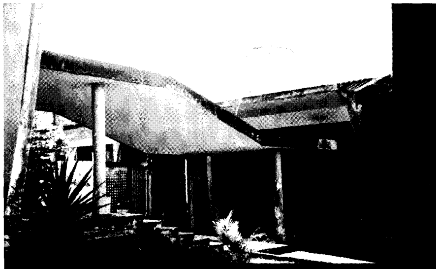
Articulação entre edifício administrativo e refeitório
