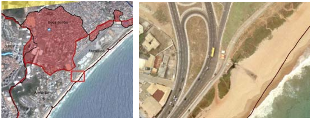
Figuras 21 e 22 – Localização e Detalhe do Bueiro de Drenagem da Bacia do Litoral Atlântico
