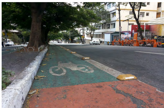
Foto 1 – Ciclovia instalada na Av. João Pinheiro, próximo à Praça da Liberdade
