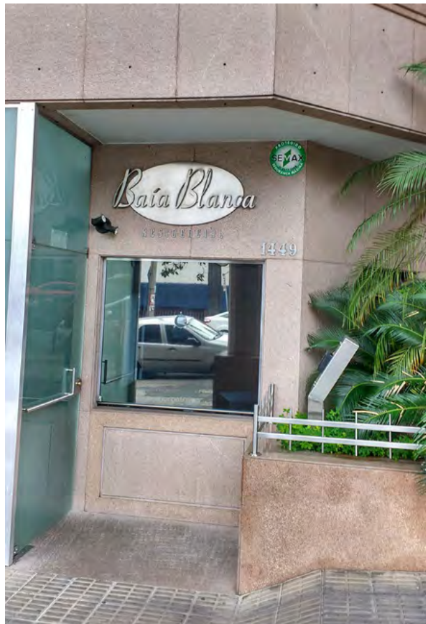
Foto 16 - Edifício Baía Blanca
