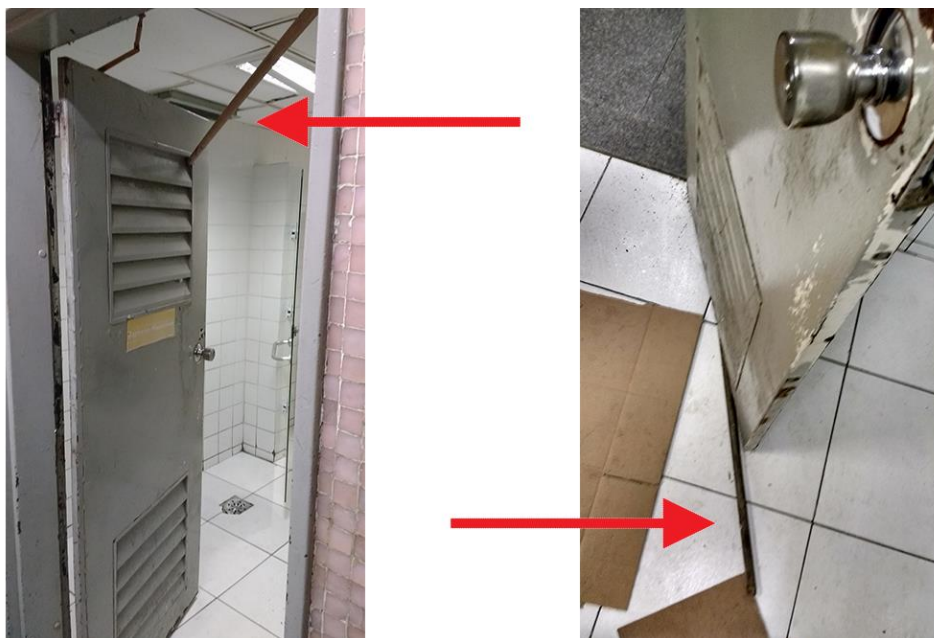
Figura 6 - 1) Cabo de vassoura na parte superior da porta de entrada (02/04/2017) 2) Imagem 2 – Cabo de vassoura entre o chão e a parte inferior da porta de entrada (02/04/2017)
