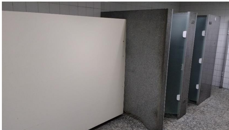
Figura 4 - Estação de metrô General Osório – Aplicação de tapume na área onde os mictórios foram removidos (02/02/2017)
