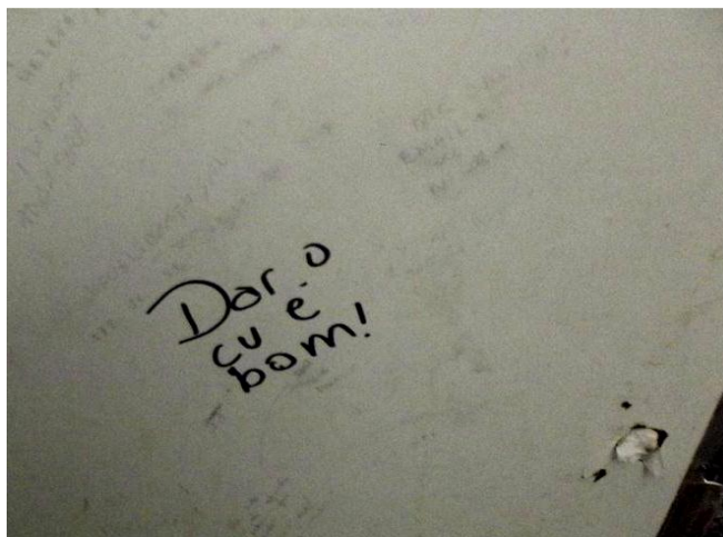
Figura 3 – Pichação na Porta do Banheiro
