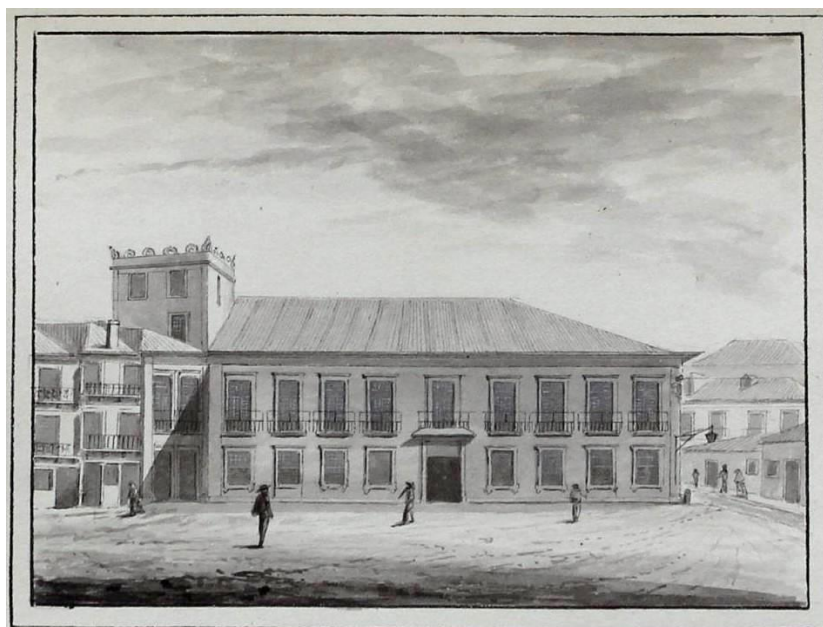
Figura 3 – Aspeto geral da fachada principal da casa nobre que foi da família dos Viscondes de Balsemão e onde esteve instalada a biblioteca.
