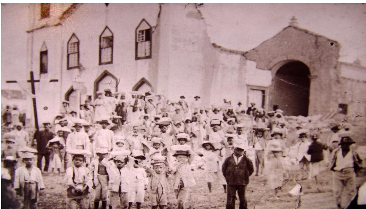
Figura 1 - Moradores de Rio de Contas na Bahia, com pedras nas cabeças na recuperação da Igreja Matriz
