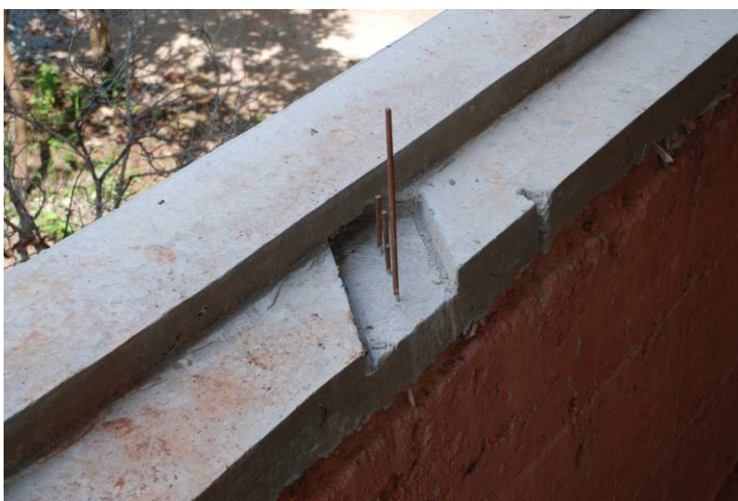
Detalhe de viga de reforço em concreto da Casa do Sítio Itaim, São Paulo-SP. 2009.
