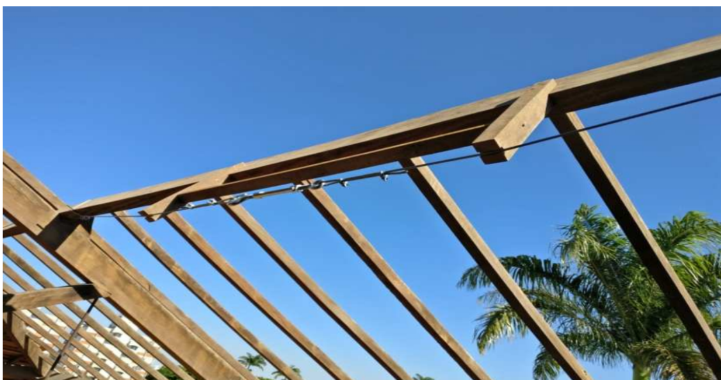
Reforço em estrutura de cobertura, Itu-SP. 2016.
