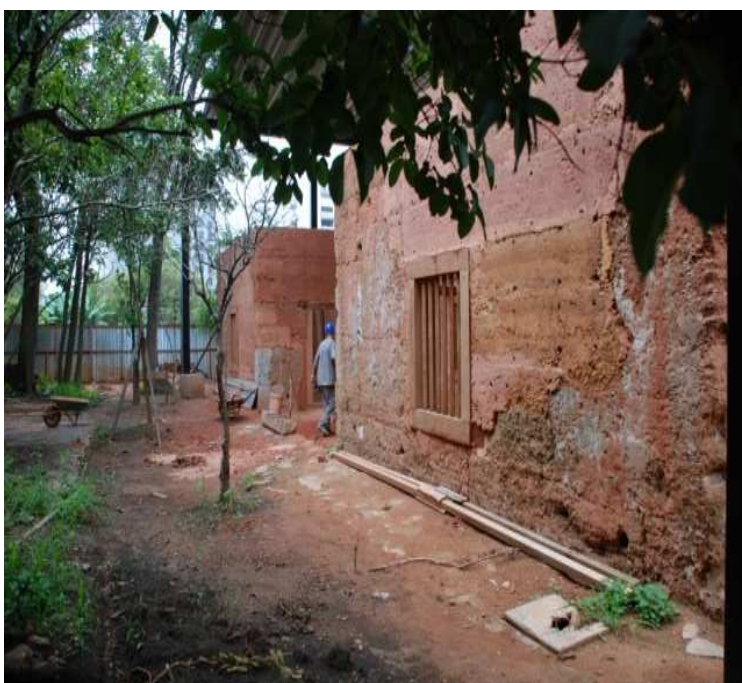
Detalhe de viga de reforço em concreto da Casa do Sítio Itaim, São Paulo-SP. 2009.
