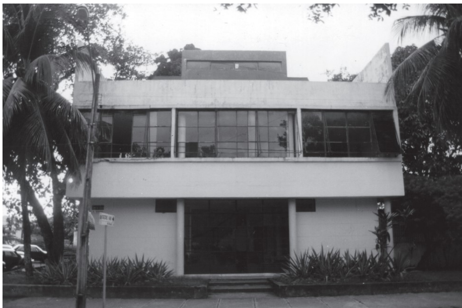
Figura 1 - Pavilhão de Verificação de Óbitos da Faculdade de Medicina, Recife, Projeto de Luiz Nunes, 1936 Fonte: Foto Eduardo Aguiar.
