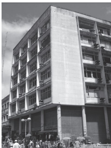
Imagem 7 - Edifício sede do IPASE Fonte: Guimarães (2009).
