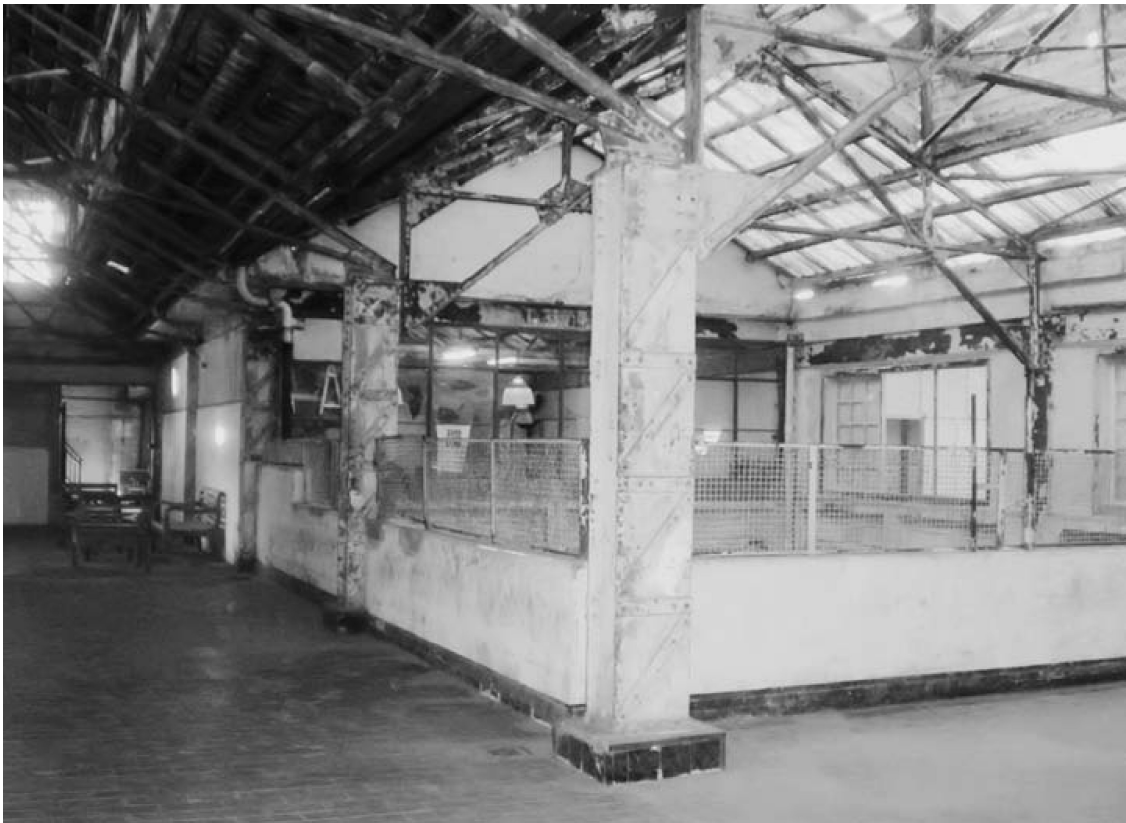
Figura 4: Vista interna da antiga Fábrica da Bhering Fonte: Arquivo pessoal (2012)
