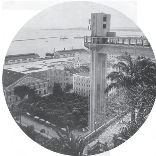
Elevador Lacerda em construção – 1931. Fonte: Acervo da Companhia Energética da Bahia
