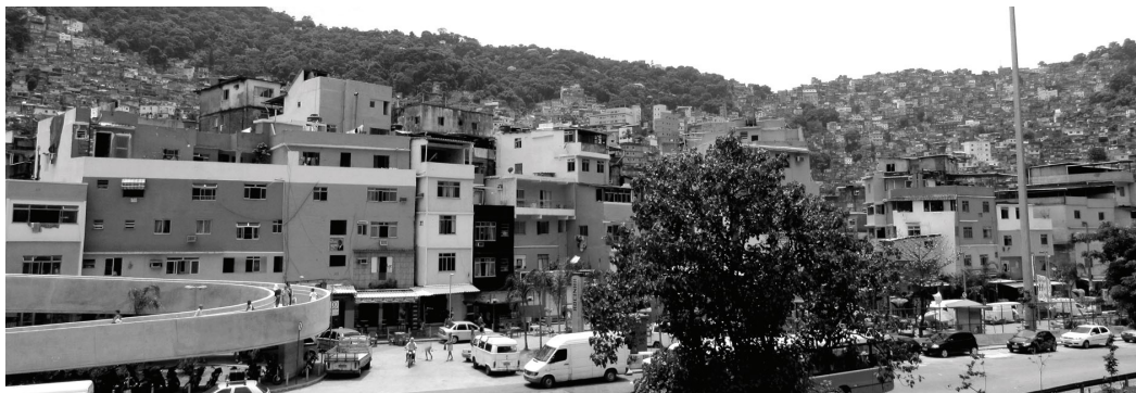
Figura 1: Favela da Rocinha, Rio de Janeiro, com as casas, apenas as voltadas para a avenida, rebocadas e pintadas.
