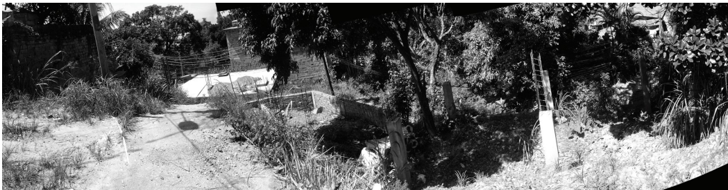
Figura 8: Trecho da Rua Boa Vista em fevereiro de 2008. Foto do autor.
