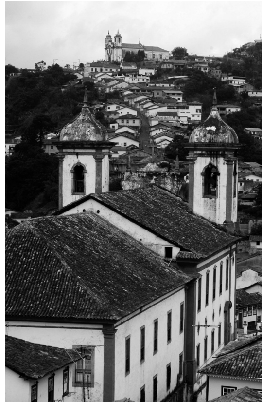
Figura 7: Acima, Morro e Igreja de Santa Efigênia e Ladeira do Vira e Saia (“caminho velho”). Abaixo, a Igreja Matriz de Nossa Senhora da Conceição de Antônio Dias, também lançada na “estrada tronco”. Um dos poucos panoramas onde é possível confirmar o desenho linear da ocupação urbana.
