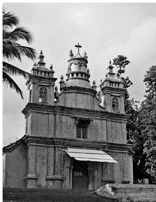
Figura 17: Capela de Nossa Senhora dos Milagres em Loutolim. Fonte: Fotografia de Sandeep Araujo, 2010.
