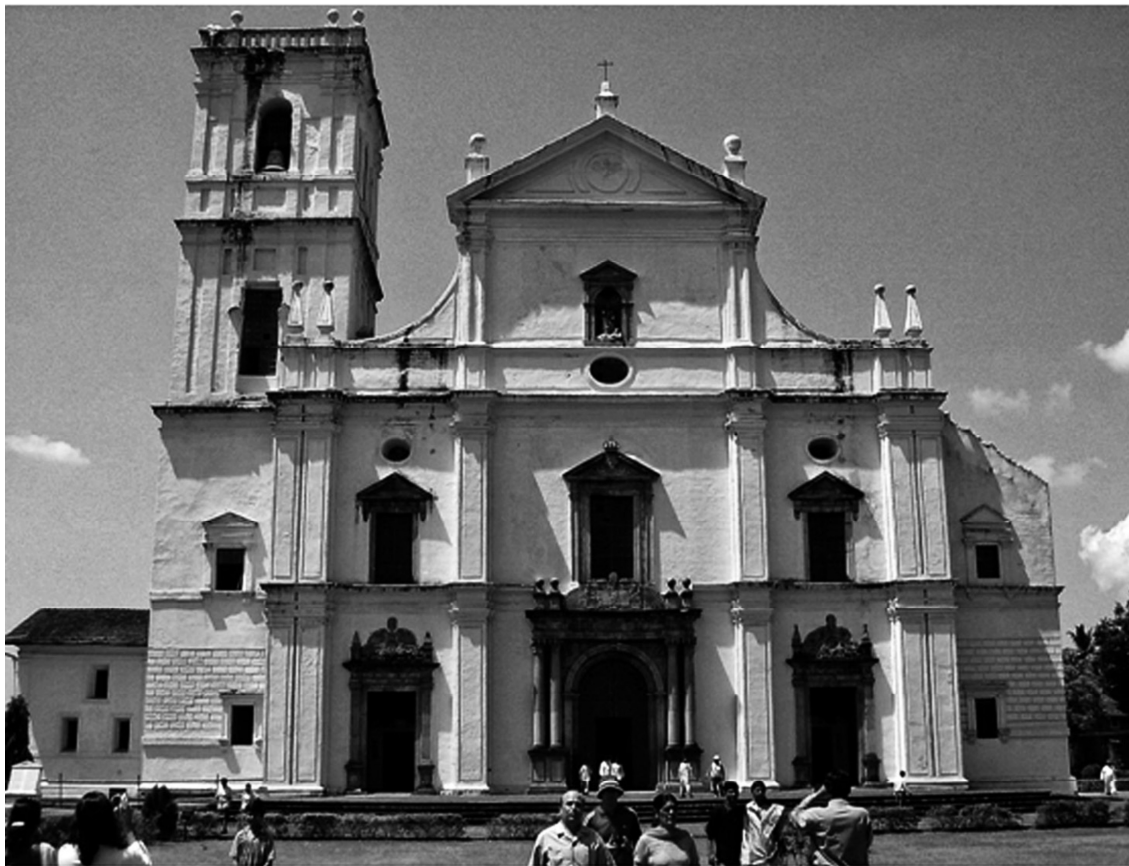
Figura 4: Fachada principal da Sé de Goa, vendo-se, à direita, os remanescentes da torre norte que desabou durante uma tormenta, em 1776, e, à esquerda, o volume correspondente à ampliação da capela do Santíssimo.
