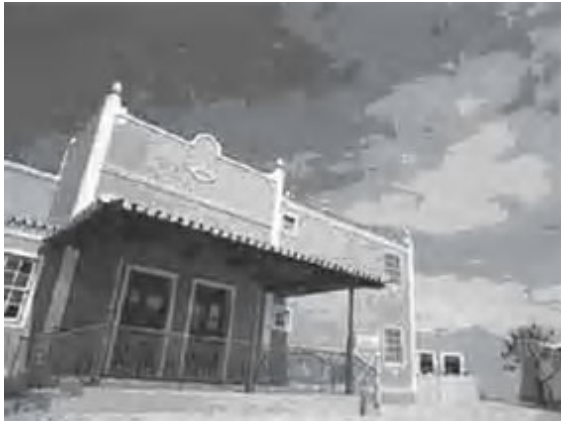
Figura 3 Autor desconhecido. Pousada Gabriela. 1 fotografia, color. Disponível em: < http://midia.brasilviagem.com/jpg/152634.jpg > Acesso em: 14 maio 2007
