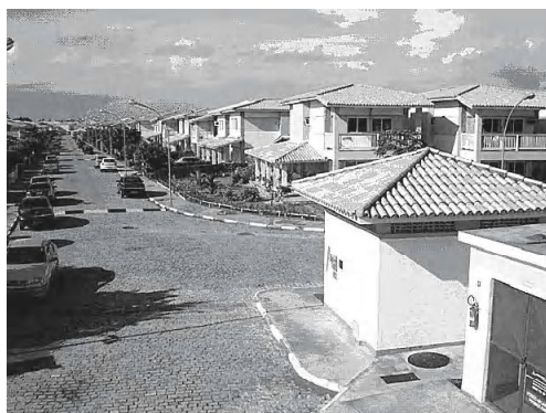
Figura 6 Lissonger, André. Condomínio Flamingos Paradise . foto, original em cores.
