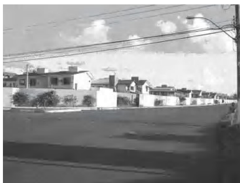
Figura 7 Lissonger, André. Condomínio Flamingos Paradise . foto, original em cores.
