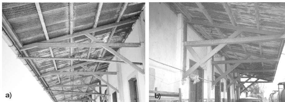
Figura 14: Plataforma de embarque, estrutura em madeira com esquema similar e cobertura com telhas metálicas. a) Júlio de Castilhos; b) São Bento.
