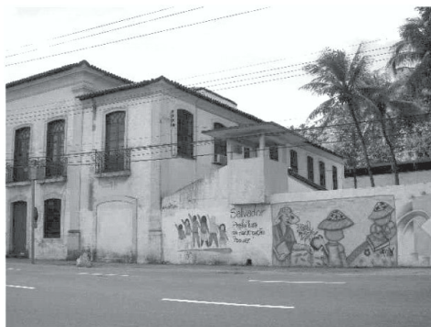
Foto 6 – Muros na lateral da Igreja Órfãos de S. Joaquim.
