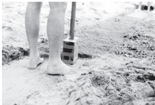
Figura 1: Fundação em solo cimento
