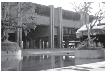
Sede da CHESF- Cia. Hidrelétrica do São Francisco Foto acervo Assis reis
