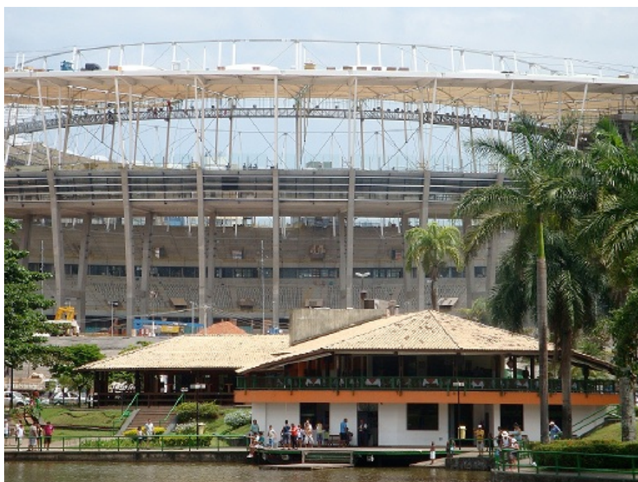
Figura 2 – Vista da Obra da Arena da Fonte Nova em 2013 (Foto: Francisco A. Zorzo)
