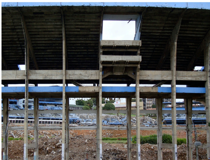
Figura 1 – Demolição do Estádio Fonte Nova em 2010 (Foto: Francisco A. Zorzo)
