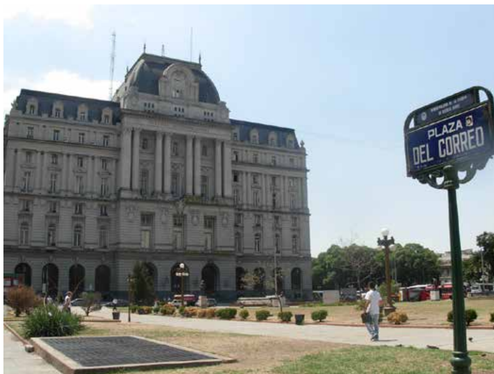
Figura 1 – El Palacio de Correos y Telecomunicaciones, antes de ser refaccionado
