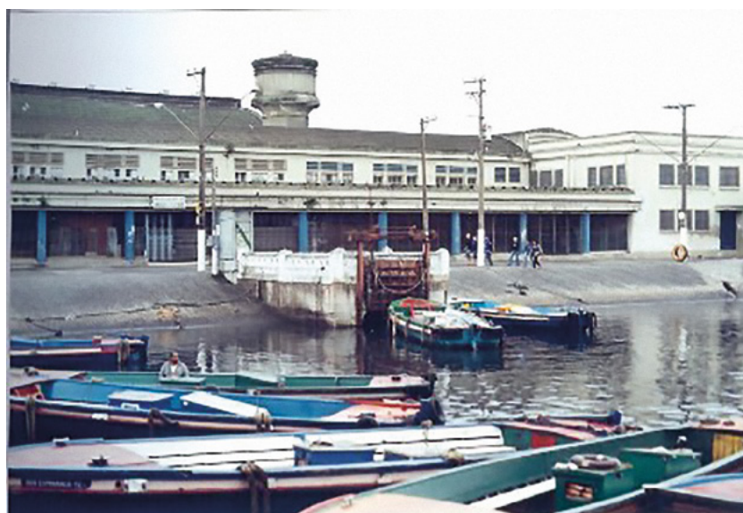
Figura 5 – Canais de drenagem de Santos
