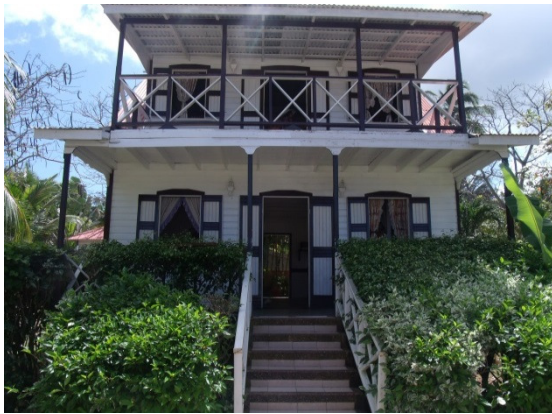
Figura 2 - Vista da fachada da edificação. Fonte: Acervo do Autor (2015).
