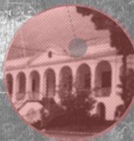
Sede da Fábrica de Pólvora Estrela, 1826, Raiz da Serra
