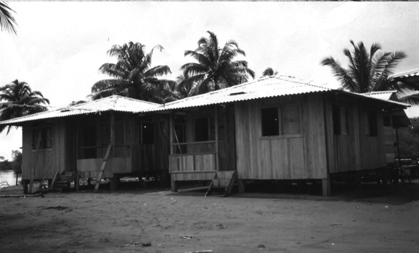
Figuras 7 e 8: Moradia rural autóctone em Huina, Baía Solano (1986) e moradias tradicionais com madeiras serradas e telhas de produção industrial em Charambirá, Valle del Cauca (1995). Fonte: Arquivo pessoal de Gilma Mosquera e Jacques Aprile-Gnisset.
