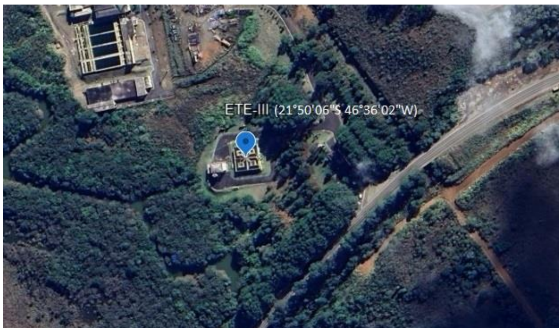
Figura 3 - Local de lançamento do esgoto tratado da ETE-III no Ribeirão das Antas
