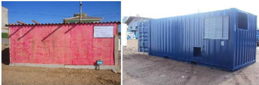
Figura 7 – Exemplo de depósitos de materiais para canteiros de obra
