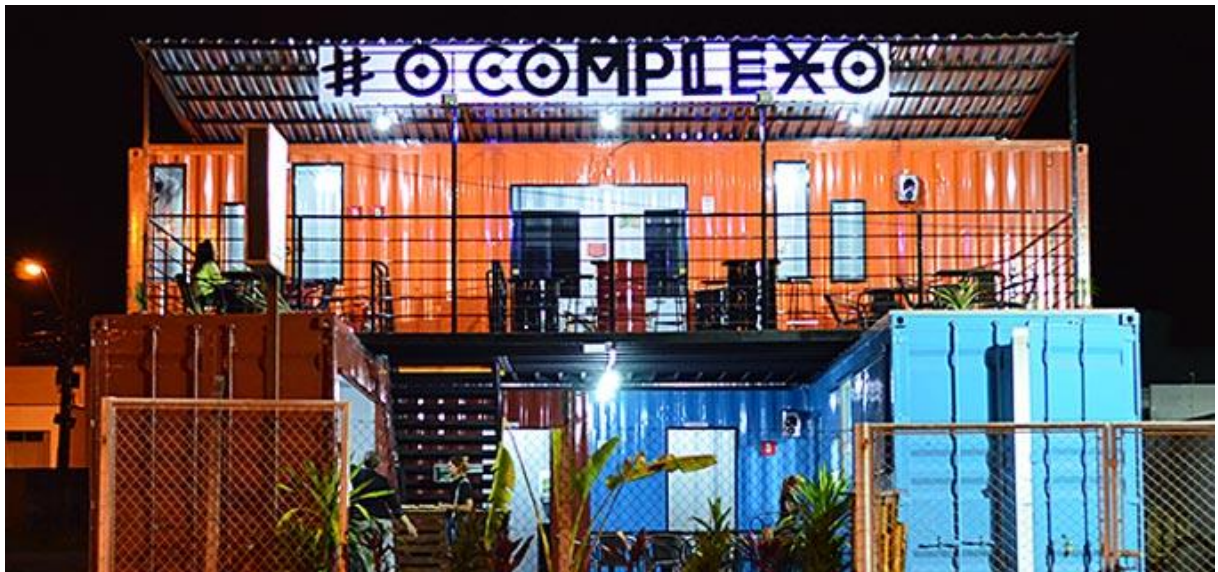
Figura 2 - Bar edificado em contêiner marítimo em Sorocaba-SP.
