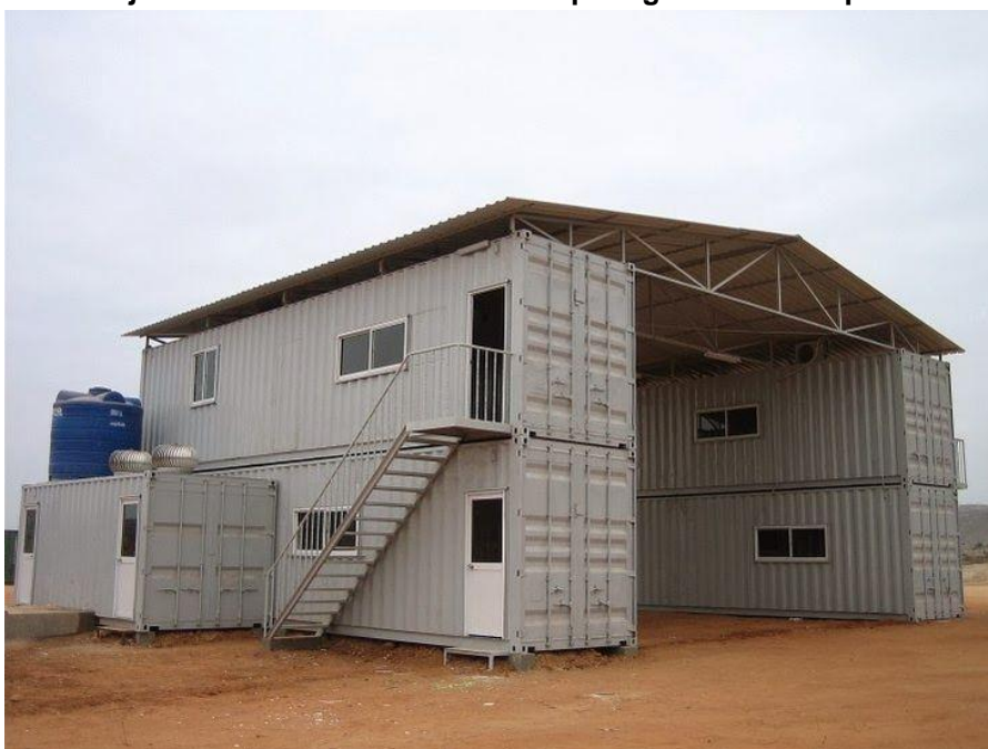
Figura 8 - Conjunto de contêineres utilizados para guarda de maquinário e alojamento.
