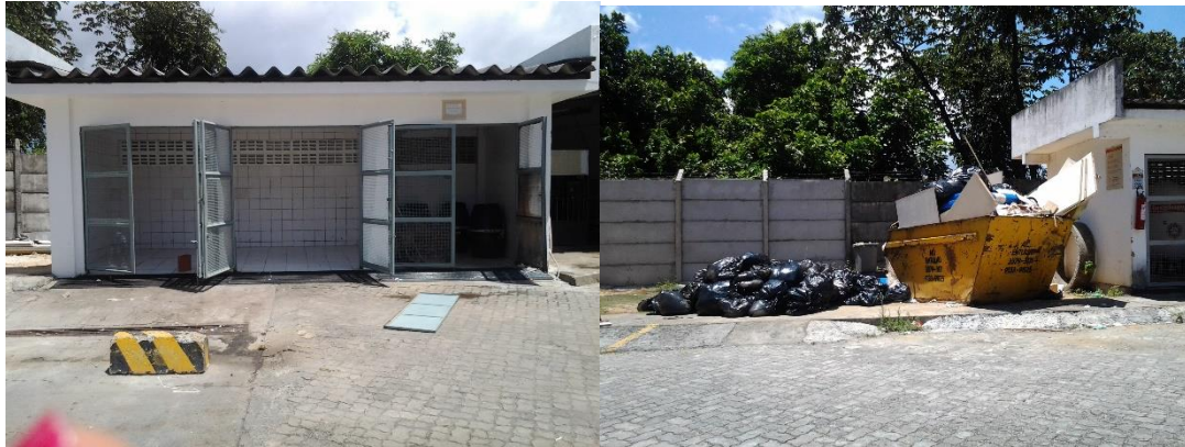
Figura 4: Abrigo e armazenamento externos dos RSS do Hospital Delta
