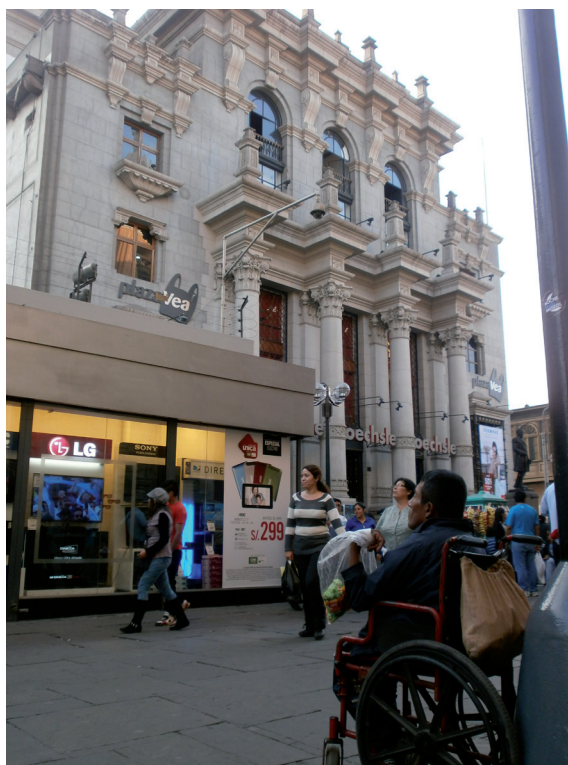
Figura 18 EDIFICAÇÃO, JIRÓN DE LA UNIÓN
