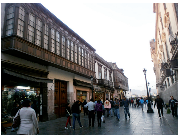
Figura 22 FACHADA DA CASA ALIAGA, COM O BALCÃO NA PARTE SUPERIOR, DOIS ESTABELECIMENTOS COMERCIAIS NA PARTE TÉRREA E A PORTA DE ACESSO À CASA NA ÁREA CENTRAL.
