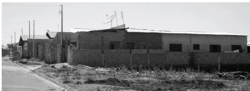
Figura 2 VISÃO LATERAL DE UMA AUTOCONSTRUÇÃO
