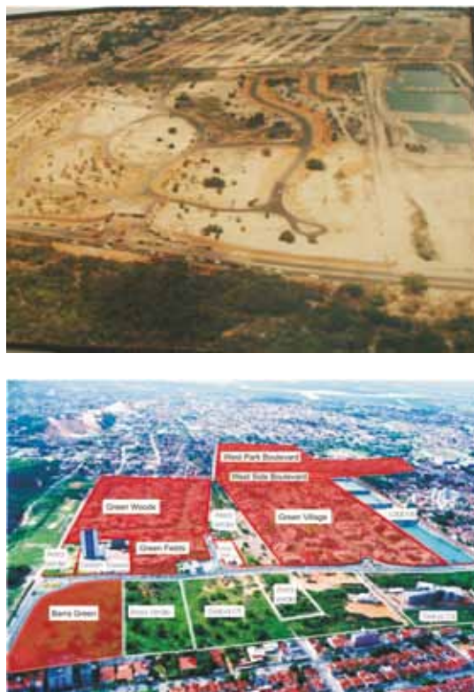
Figura 1 TERRENO ANTES E DEPOIS DA PRODUÇÃO DOS CONDOMÍNIOS HORIZONTAIS
